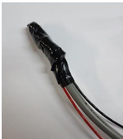
（図 9-3 絶縁処理 1） 絶縁処理例（ビニールテープ）
